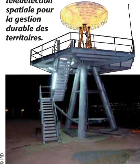
La plate-forme de télédétection SEAS-Guyane.
