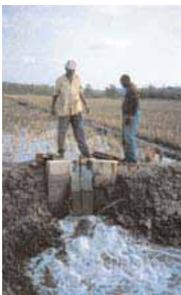
Ouverture d'une vanne dans le polder expérimental de Yangoua.
