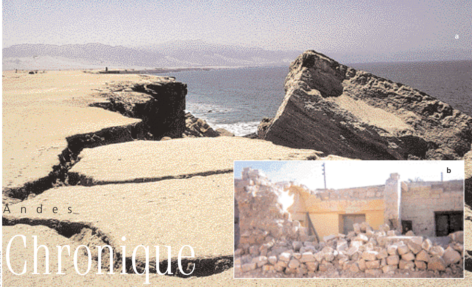
a. Dégâts créés en bordure de falaise (partie nord de la baie d'Antofagasta) lors du tremblement de terre de 1995.
