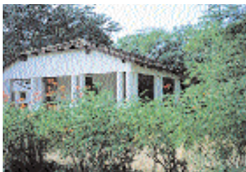
Bâtiment de la station de Mbour.
