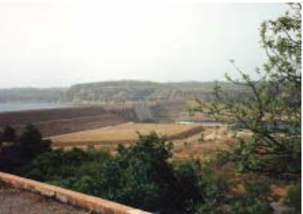
Barrage de Manantali.
