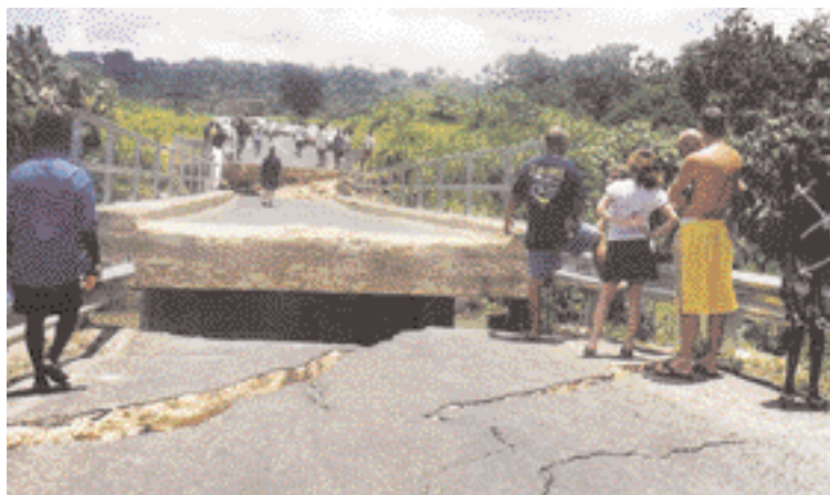
Le pont de la Teouma sur la route circulaire de l'île à la sortie de Port Vila : affaissement des piliers et basculement du tablier. Le pont, totalement détruit, devra être reconstruit.
