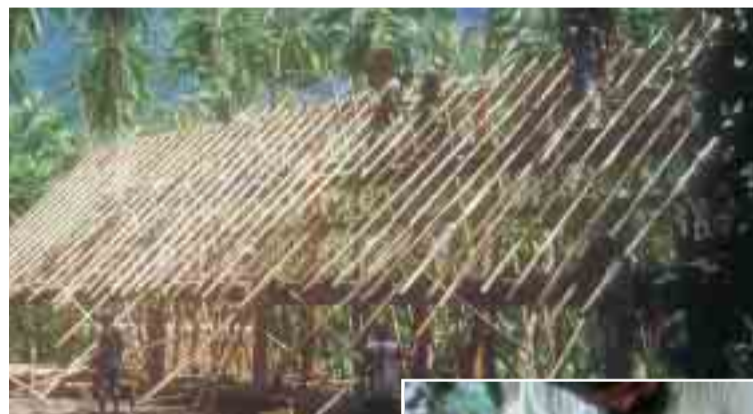
Après avoir restauré la plate-forme lithique, la superstructure est reconstruite d'après les données archéologiques et ethnohistoriques. La charpente sera couverte de palmes de cocotier tressées. Certains gros travaux, ou ceux qui nécessitent une rapidité d'exécution, sont l'occasion de réactiver les liens de solidarité et la participation de nombreux bénévoles.
