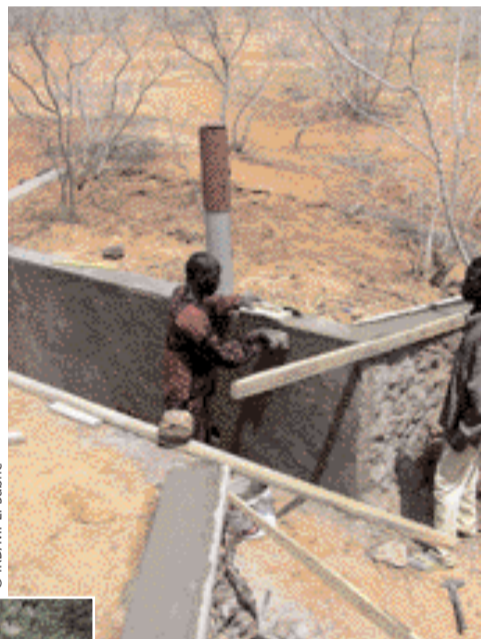
Construction par l'IRD d'un petit canal (programme Analyses multidisciplinaires de la mousson africaine) qui permet de jauger le débit de l'eau lors de fortes pluies.
