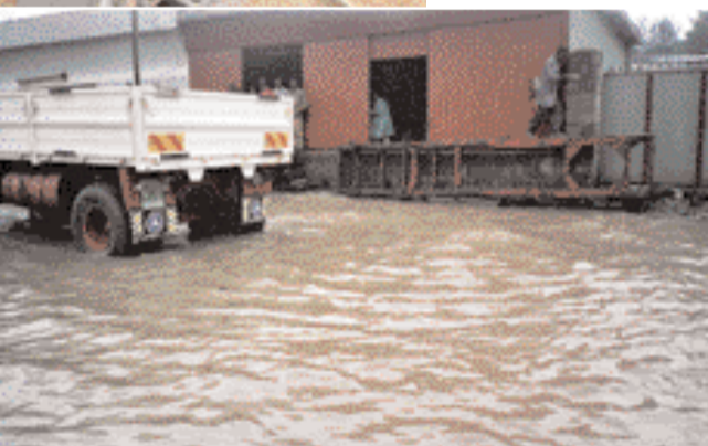
Vues d'Addis-Abeba, Ethiopie, après une forte pluie : la saturation du réseau d'évacuation des eaux de ruissellement se conjugue aux fortes pentes pour créer une inondation momentanée dans les parties basses des grands axes de circulation.
