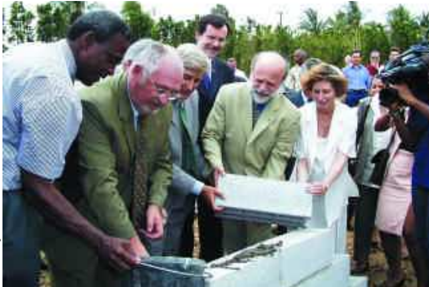
La pose de la première pierre du Pram en mai 2000 par D. Bellion, préfet de la région Martinique.
