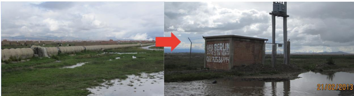
Canalisation d'eau usée de la ville de El Alto (Bolivie) vers la station de traitement, percée afin d'irriguer les champs périphériques. L'eau usée se déverse autour d'un puits de pompage d'eau potable et dans sa zone de recharge (Photo Céline Duwig)
